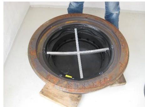
Färdig monterat enligt bild.
