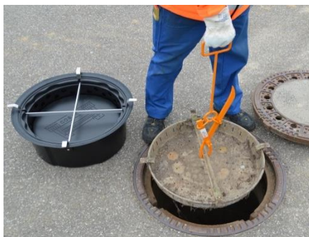
Tag bort existerande löv och sandfång.
