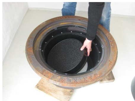
Montera sifon med filter.
